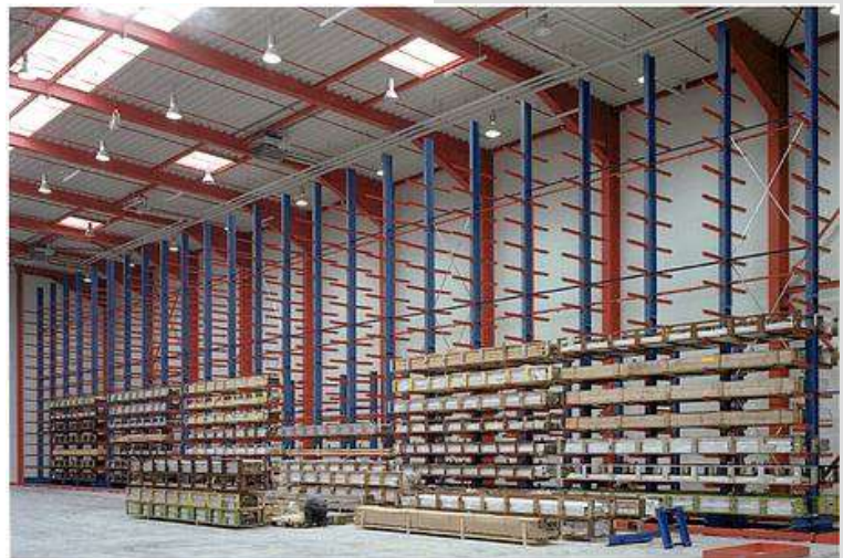
12 m hohe Kragarmregalanlage für Kassetteneinlagerung
